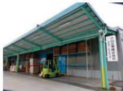
本社サービスセンター 小玉倉庫
